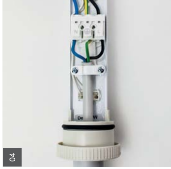
04. Anschlüsse verbinden. Kabel in Zugentlastung richtig platzieren. Zugentlastung zudrehen.
